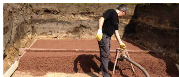
Bild 19, pooltec® Abziehen mit Hilfe der Schalung
