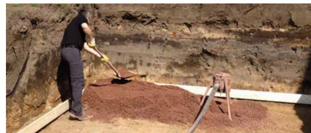
Bild 18, pooltec® Verdichten mit Schaufel
