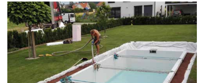
Bild 11, Einbringung mittels Gummischlauch
