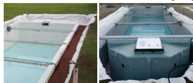
Bild 9, mit Geotextilvlies ausgelegte Baugrube
