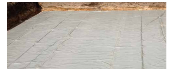
Bild 23, mit Plane abgedeckter pooltec® Boden
