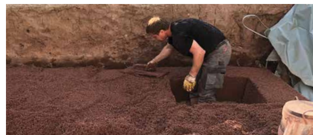
Bild 17, Aussparung Ablauf
